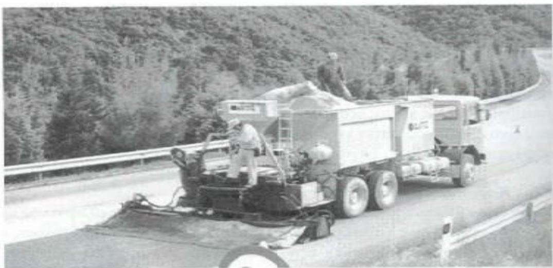
Φωτογραφία 1. Μηχάνημα παραγωγής και διάστρωσης μιγμάτων slurry
